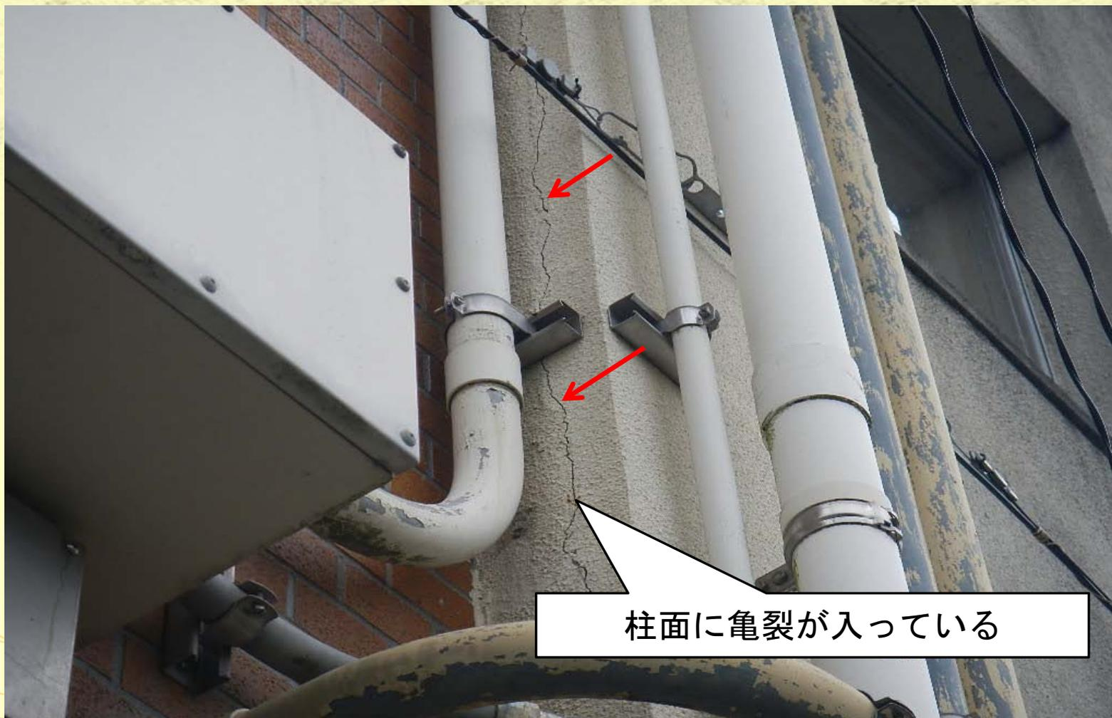
柱面に亀裂が入っている
