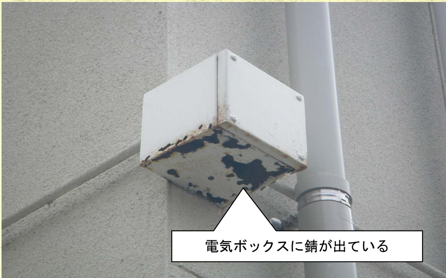
電気ボックスに錆が出ている
