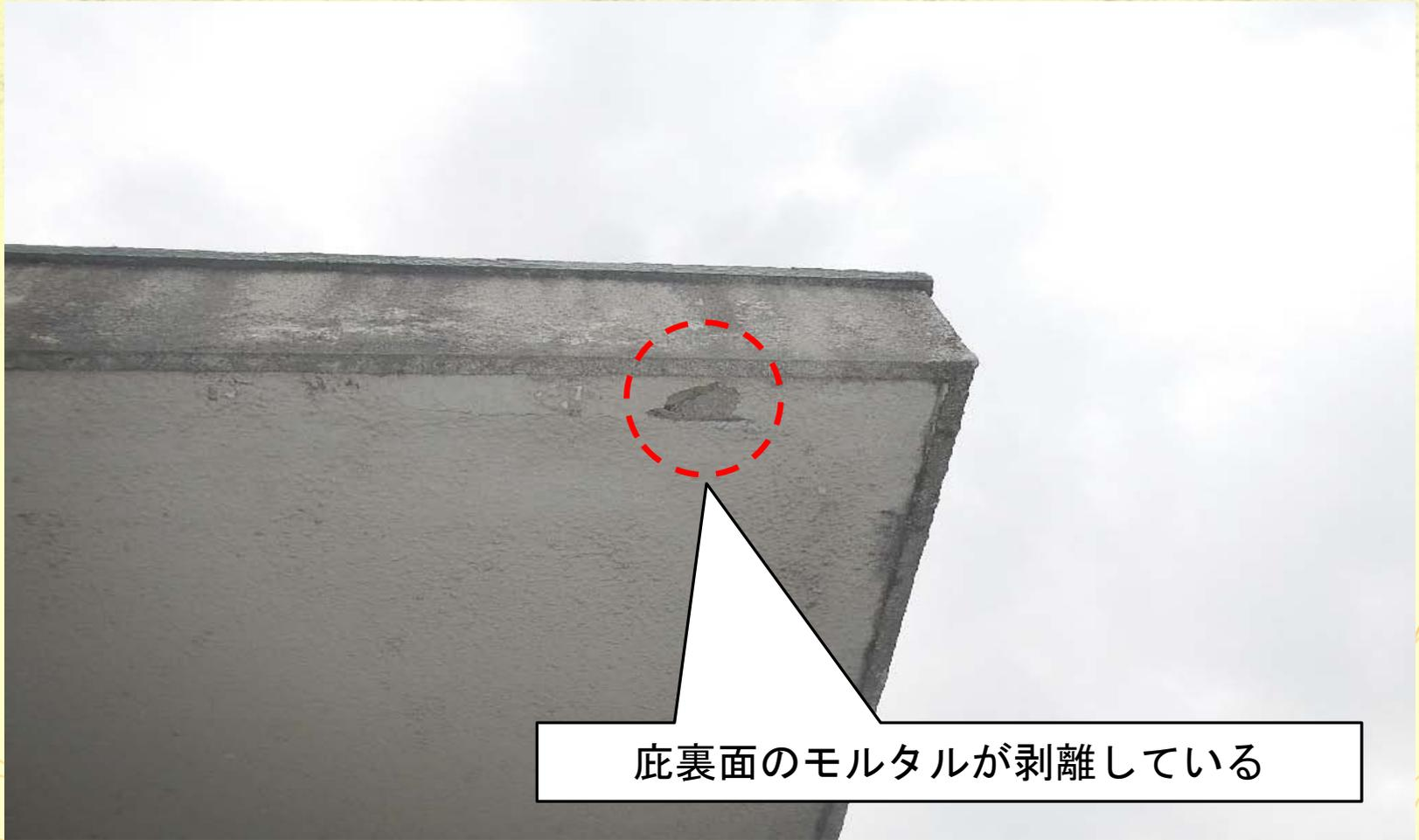
庇裏面のモルタルが剥離している
