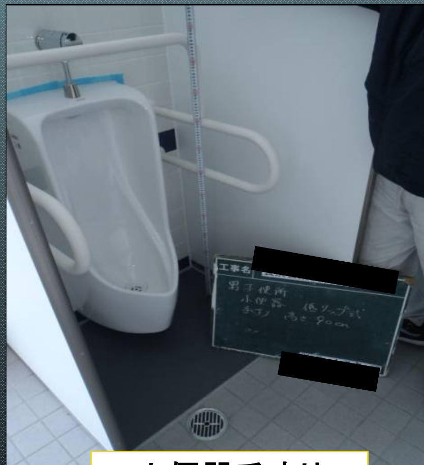
小便器手すり
