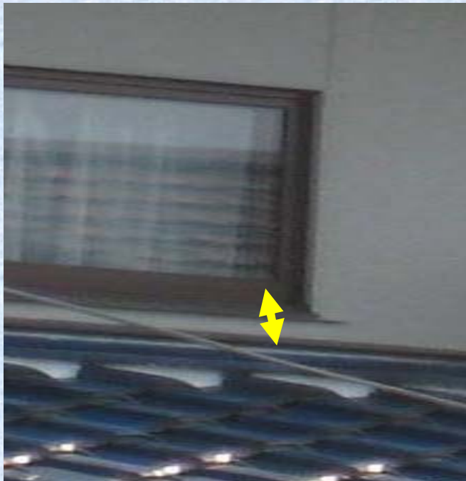
防水施工がし難い部分
