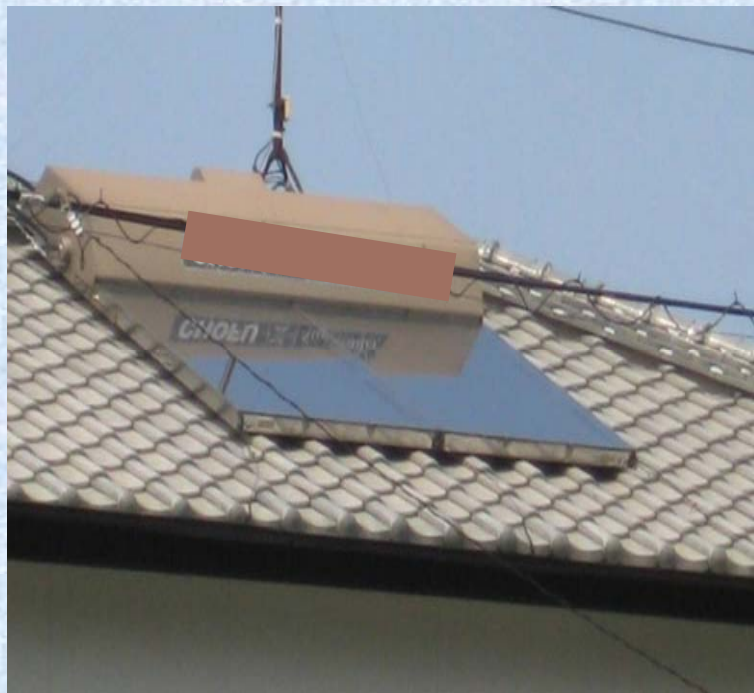
太陽熱温水機・エアコン室外機の設置
