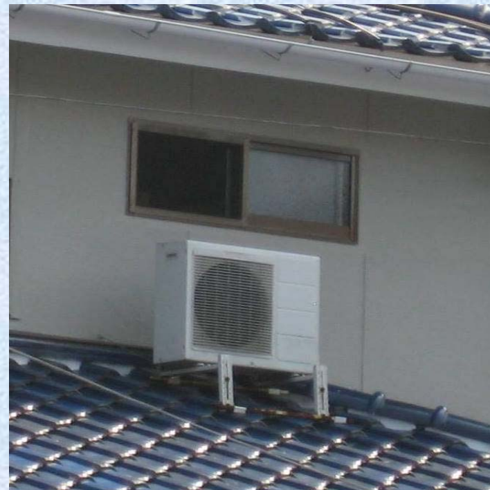
太陽熱温水機・エアコン室外機の設置
