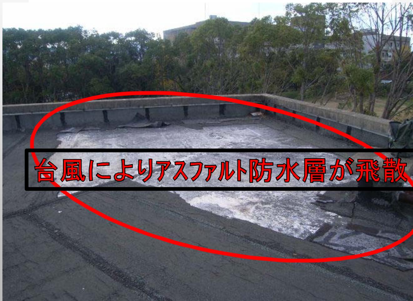
台風によりアスファルト防水層が飛散
