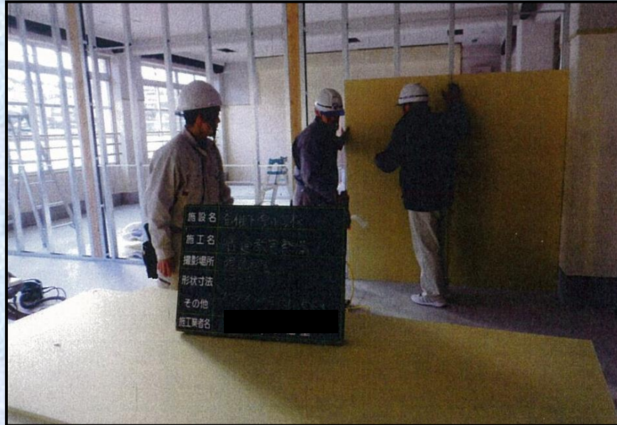
間仕切り設置工事
