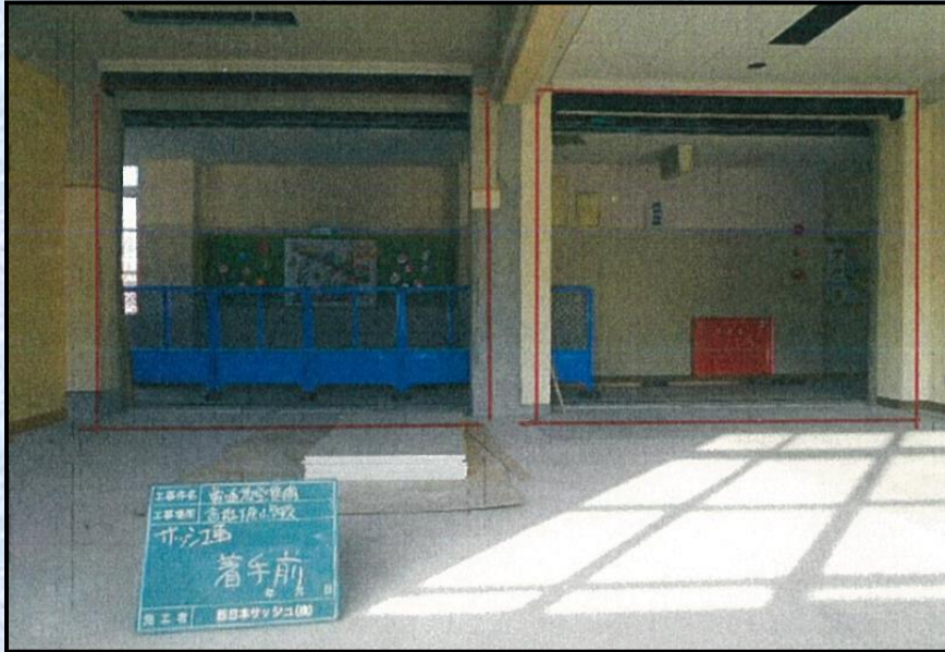
壁材，建具等撤去
