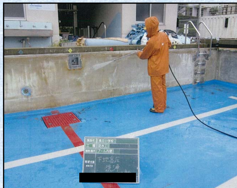
高圧洗浄 状況
