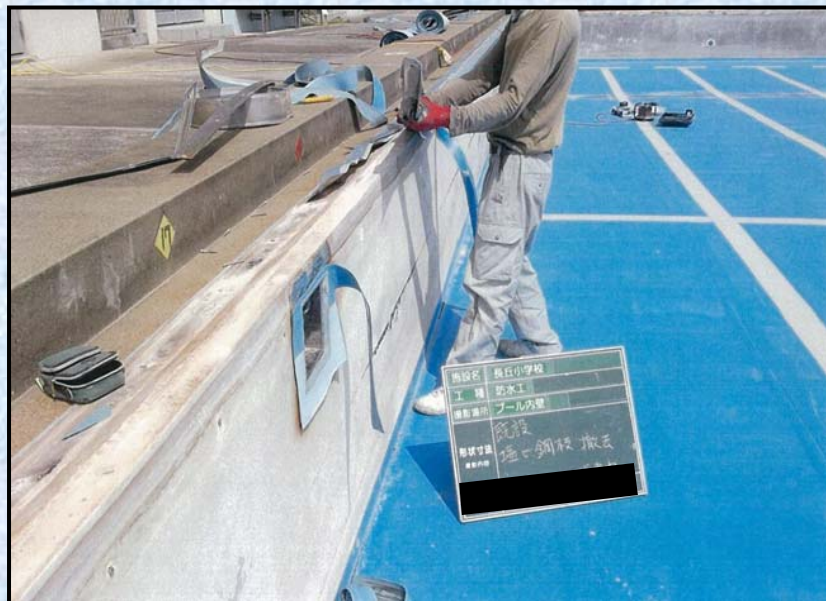
既存鋼板撤去 状況
