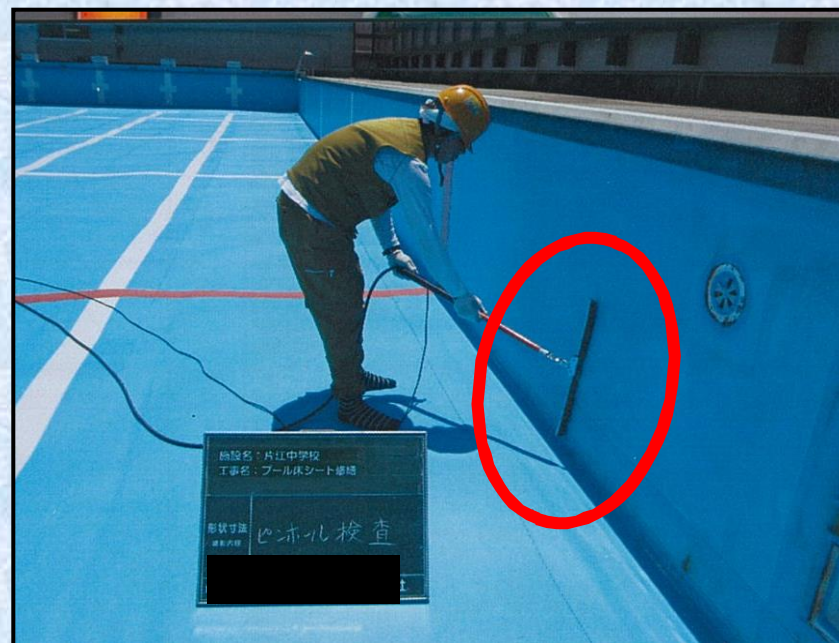
溶着検査状況
