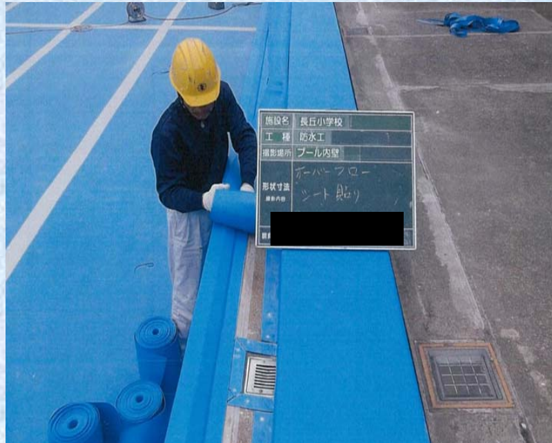
プールサイド防水シート貼状況
