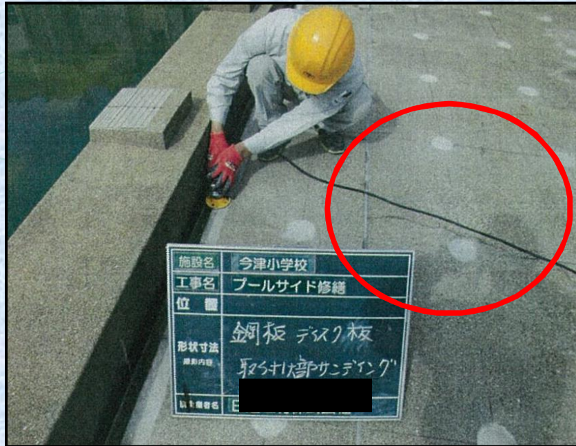
防水シート貼り合わせ状況
