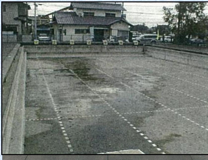
プール防水改修着手前(防水塗装)
