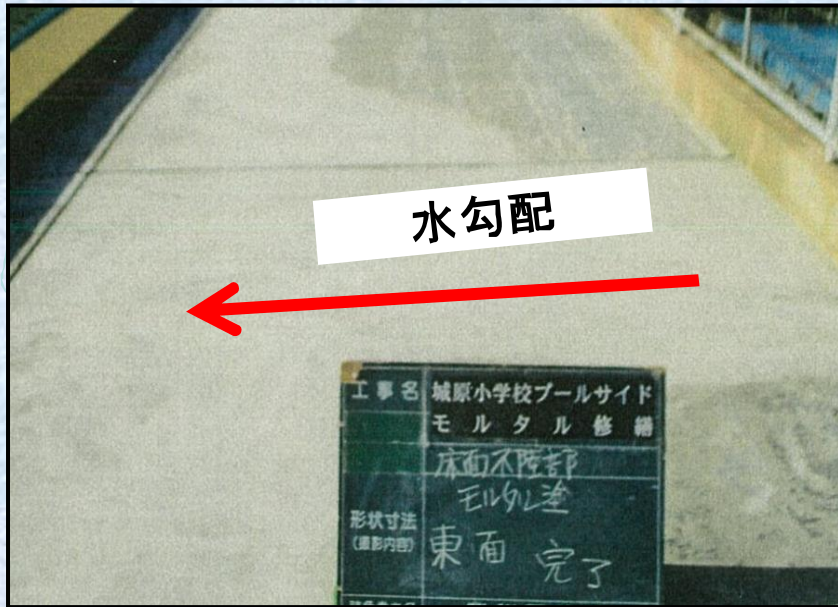
通路部分モルタル補修 完了
