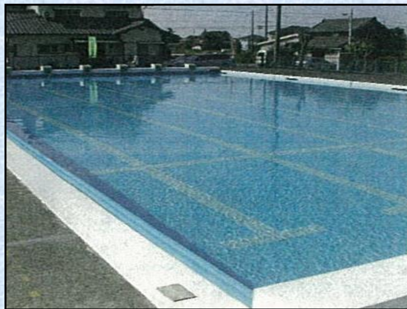
プール防水改修完了 (シート防水)
