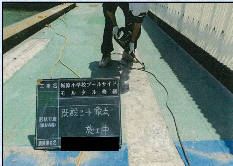
防水シート撤去 状況
