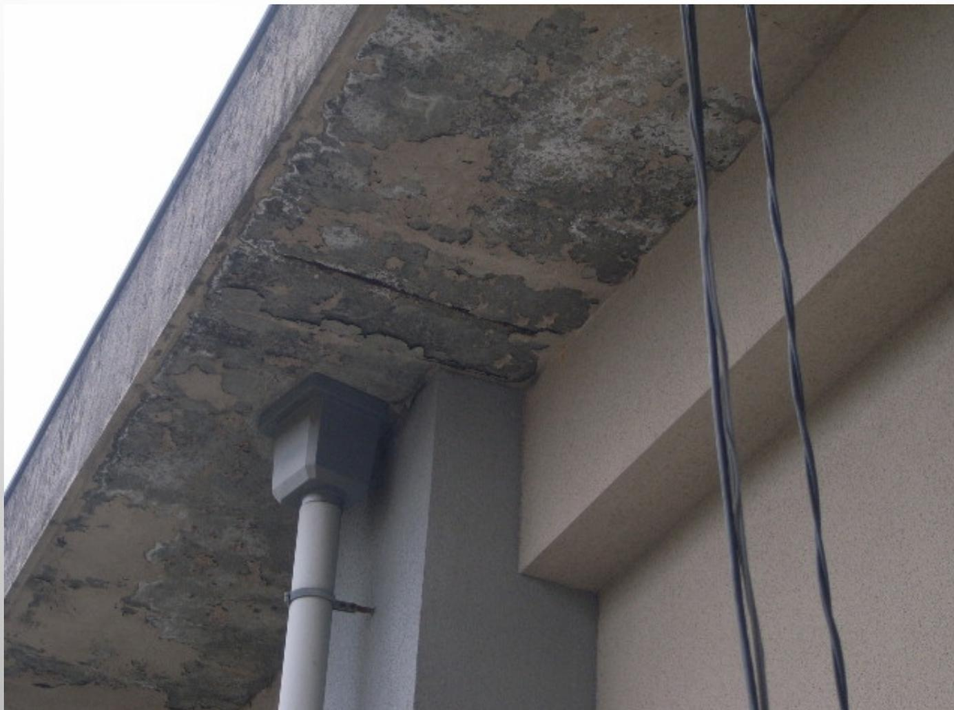
漏水によりあげ裏のコンクリートが爆裂している
