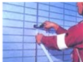
バックアップ材の施工
