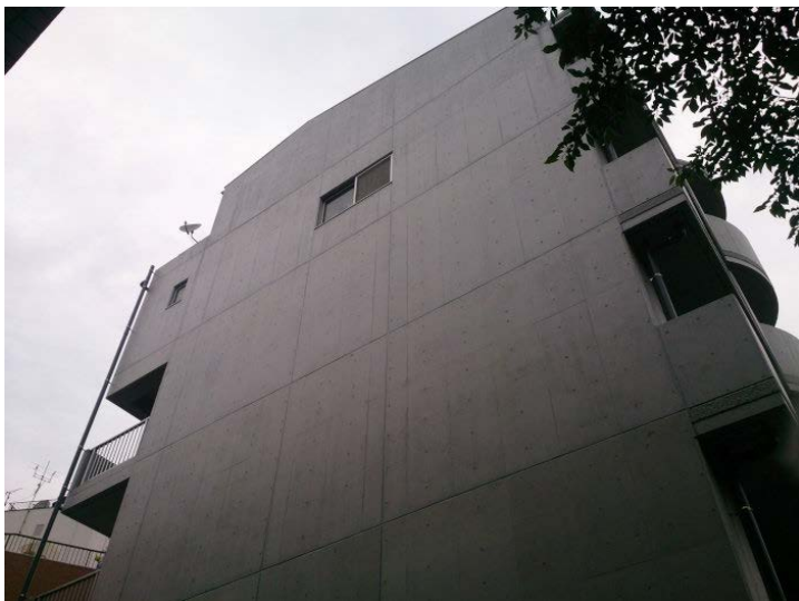
RC（鉄筋コンクリート）構造の目地
