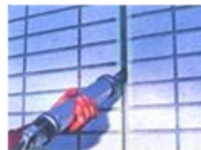
シーリング材の充てん
