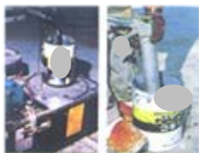
シーリング材充てんの 準備
