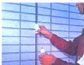
施工面の清掃
