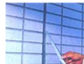
マスキングテープの 除去
