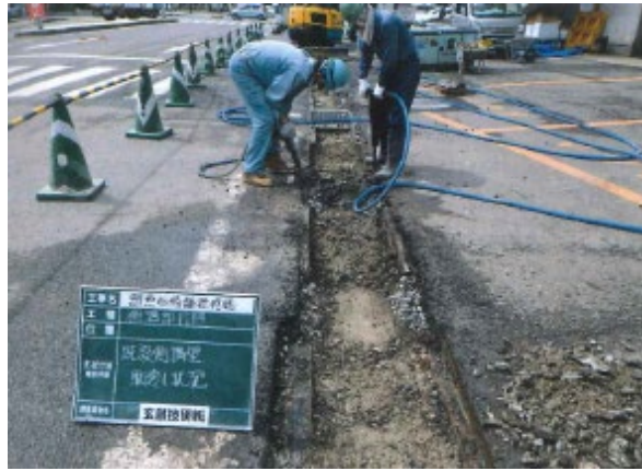
② 既設側溝等撤去
