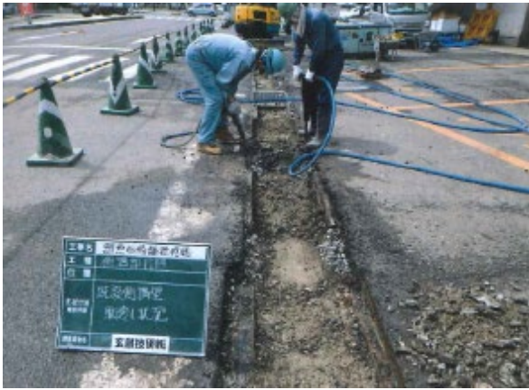
② 既設アスファルト等撤去
