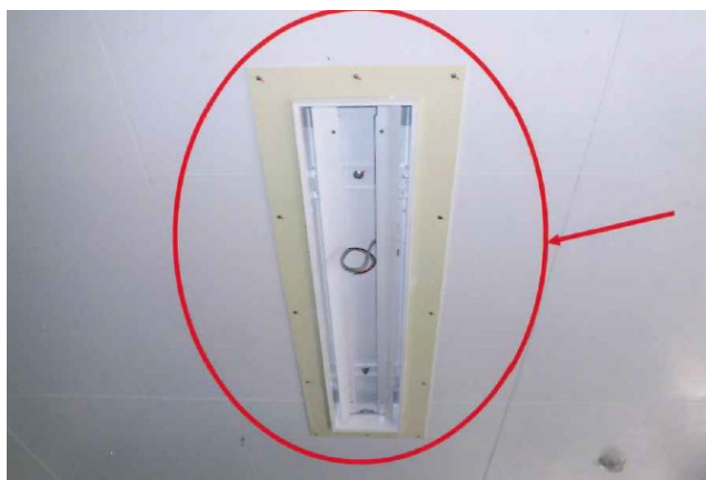
③ LED照明器具取付
