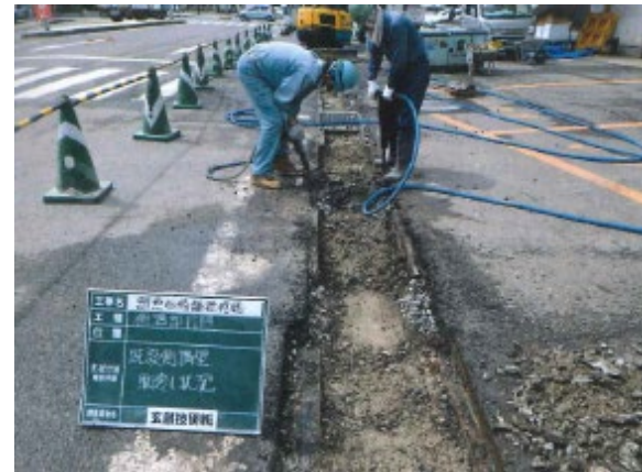
② 既設アスファルト等撤去
