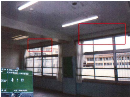
空調室内機取り付け前
