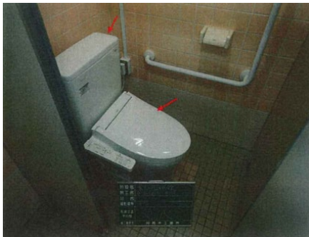
新設洋式便器及び手摺等 取付完了
