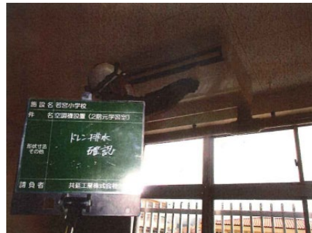
空調室内機施工状況
