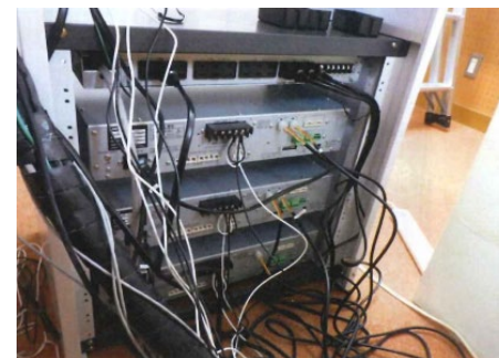
新設放送卓配線状況
