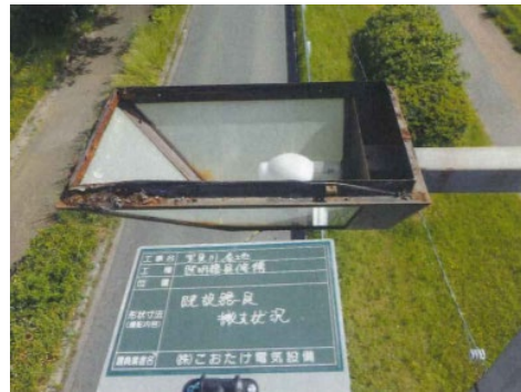
既設照明器具の撤去現況
