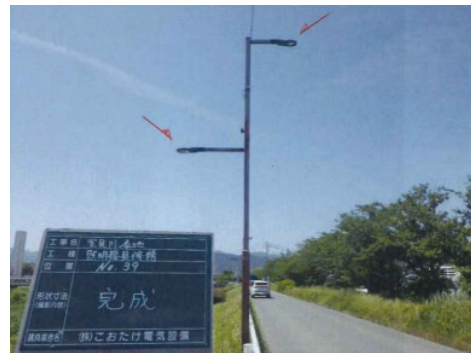
新設照明器具(LED) 取付完了
