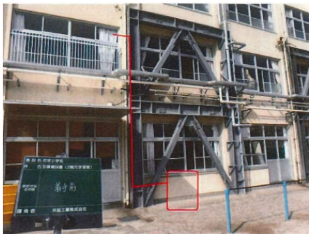
空調室外機取り付け前
