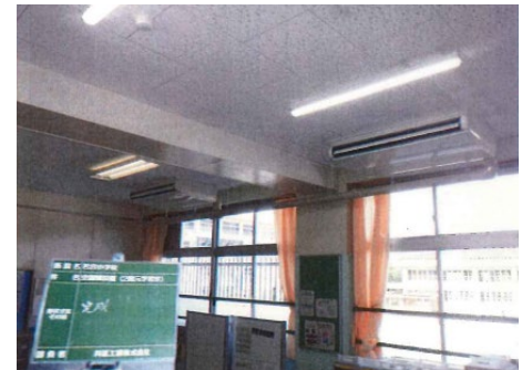
空調室内機取付完了
