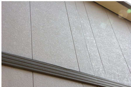
外壁サイディング
