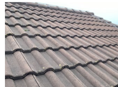
屋根セメント瓦
