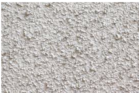
外壁モルタル
