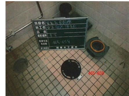
撤去跡タイル補修
