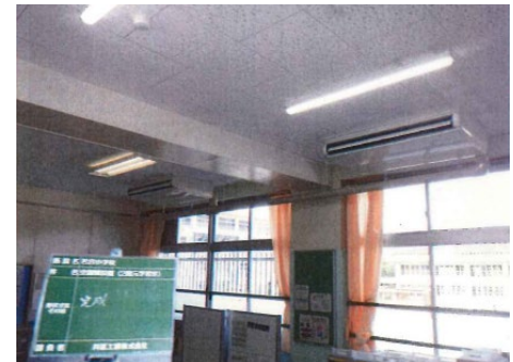
空調室内機取付完了
