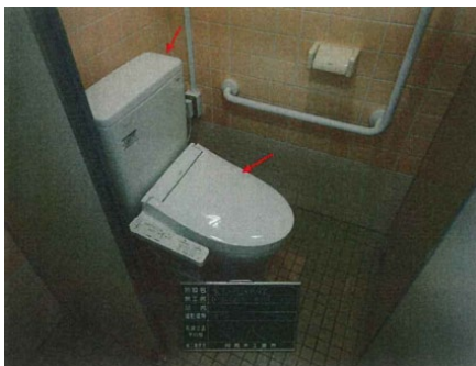
新設洋式便器及び手摺等 取付完了
