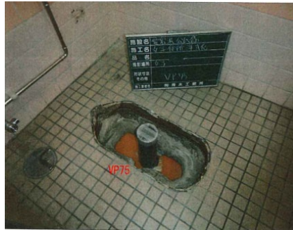
既存和式便器撤去
