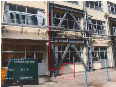
空調室外機取り付け前
