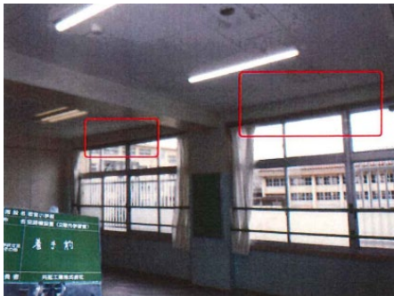
空調室内機取り付け前
