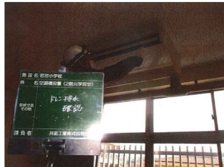
空調室内機施工状況
