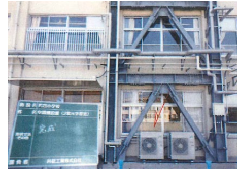
空調室外機取付完了
