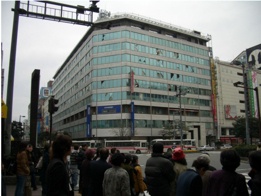
ガラスの破損落下
