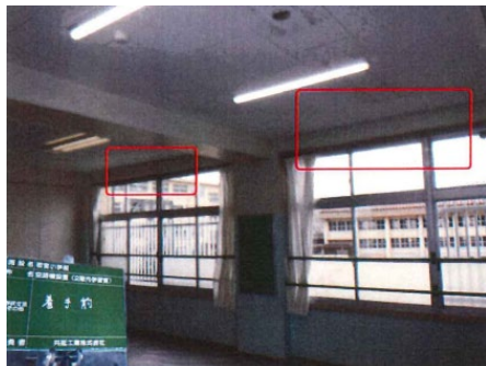
空調室内機取り付け前
