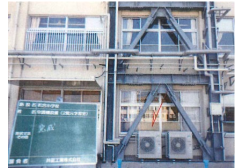
空調室外機取付完了
