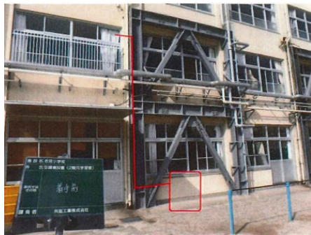
空調室外機取り付け前
