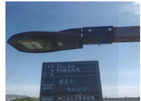
新設照明器具(LED) 取付状況
