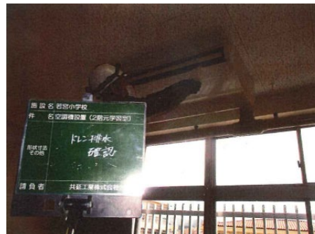
空調室内機施工状況
