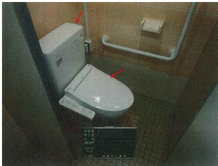
新設洋式便器及び手摺等 取付完了
