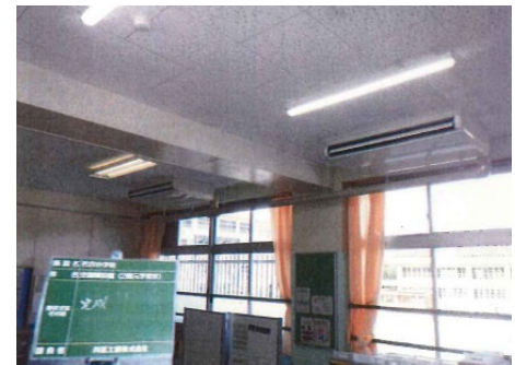
空調室内機取付完了
