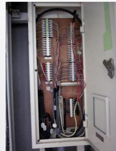
[端子盤内の設置参照]
