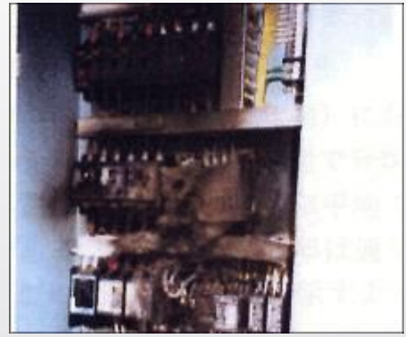
【分電盤への影響】 ※大電流による破壊
