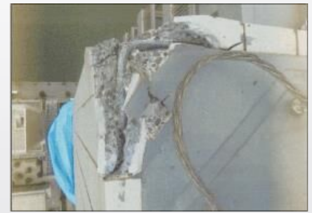
【雷直撃によるコンクリート破壊】
