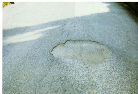
写真 8-2 陥没したアスファルト舗装
