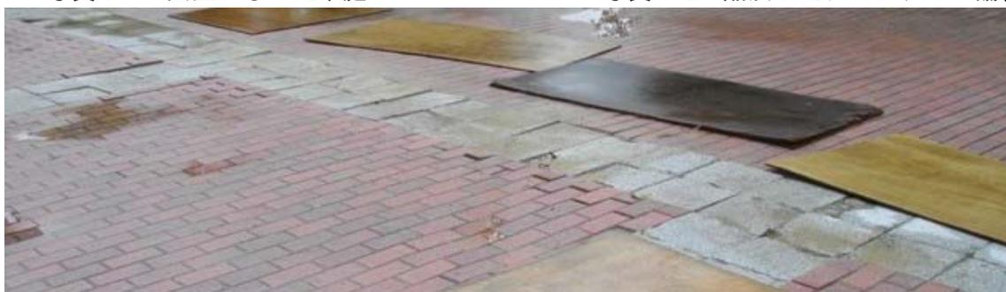
写真 8-3 破損したインターロッキング
