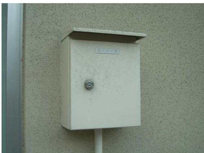
写真 1-7 手元開閉器盤（空調電源盤）
