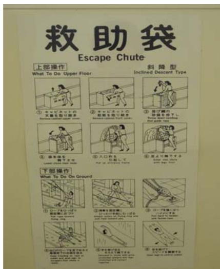
左記写真のような操作方法を示したものが救助袋のキャビネットに貼り付けてありますので、日頃から操作方法の確認をしておいてください。
