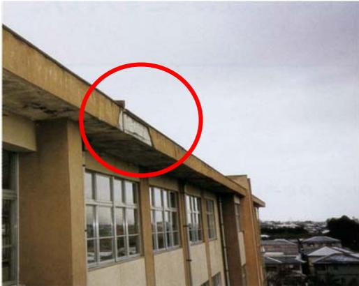
写真 1-1 庇のモルタル欠け落ち
