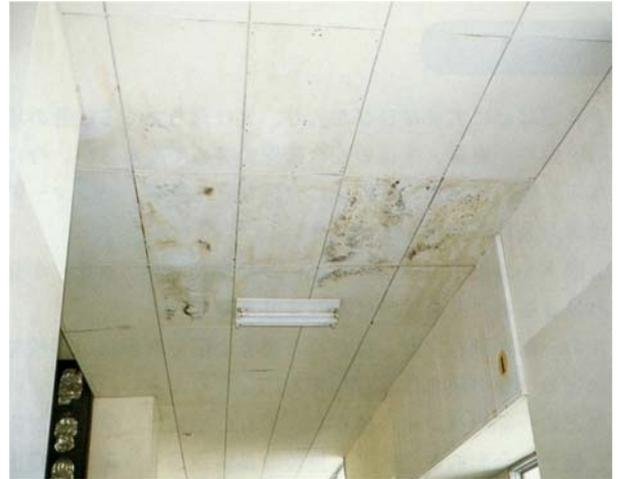
写真 2-2 雨漏り等による天井のしみ
