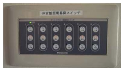
写真 2-6 昇降装置操作スイッチ
