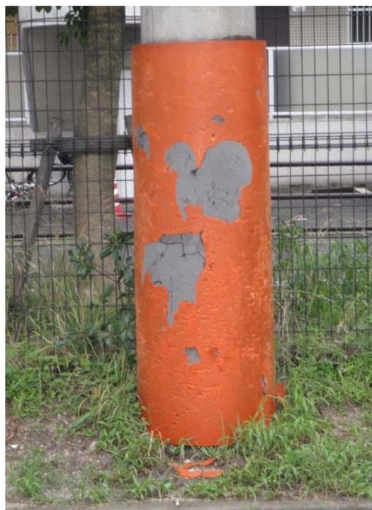
写真 7-3 破損したセーフティガード
