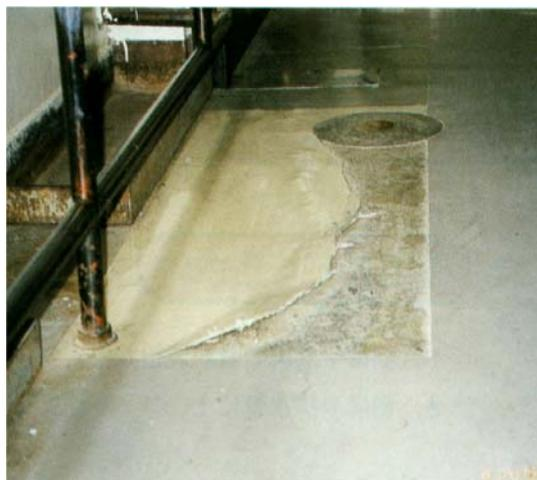
写真 2-12 床シートの破れ
