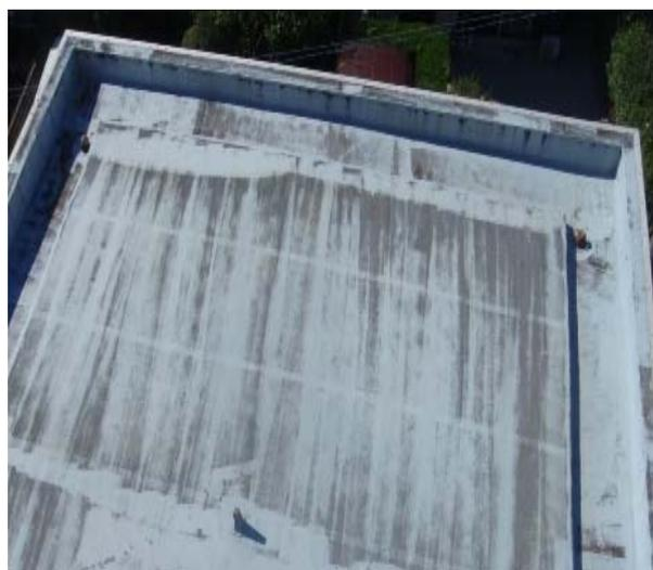
写真 1-3 塗膜防水の劣化
