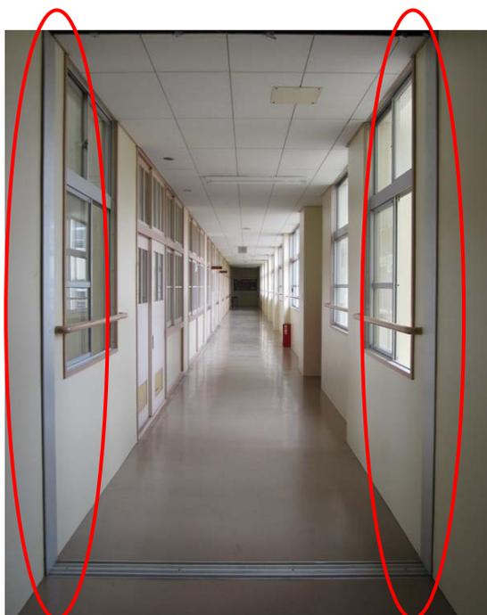
写真 2-7 内部壁の Expansion ジョイント
