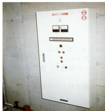
写真5-12 消火ポンプ制御盤
