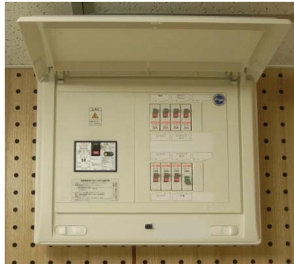
写真 1-4 プラスチック製分電盤
