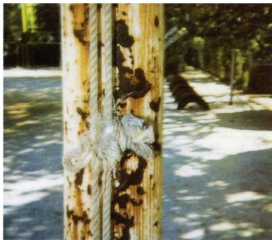
写真 3-2 昇降ロープの劣化
