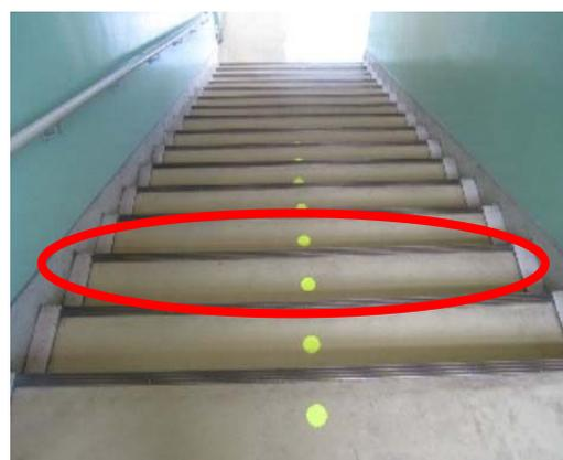
写真 2-14 階段の滑り止め金物
