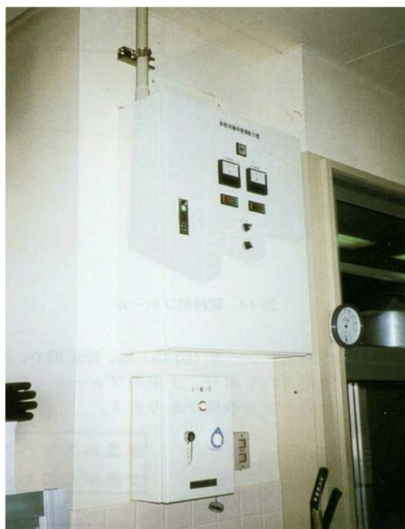
写真 1-6 食缶消毒保管庫動力盤
