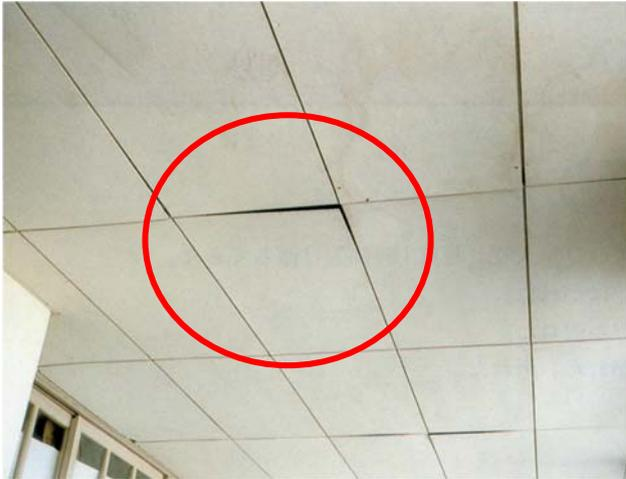
写真 2-1 天井ボードの外れ
