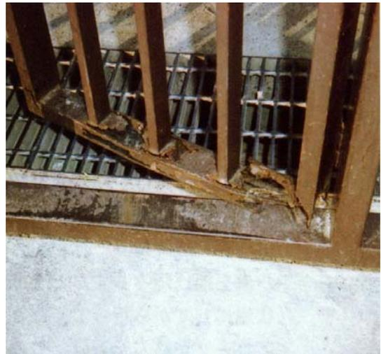
写真 2-2 門扉の格子の破損
