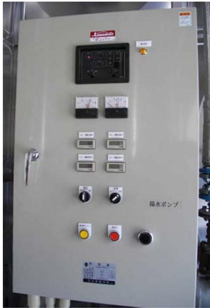
写真 1-1 揚水ポンプ制御盤
