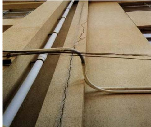
写真 1-2 外壁のひび割れ
