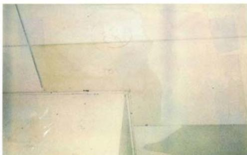
写真 3-1 天井漏水
