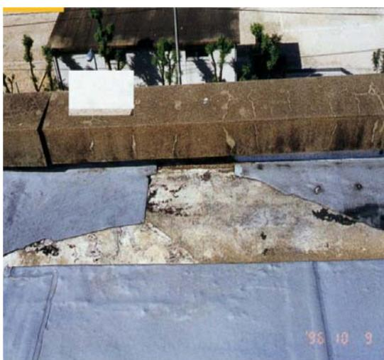
写真 1-4 防水シートの破れ
