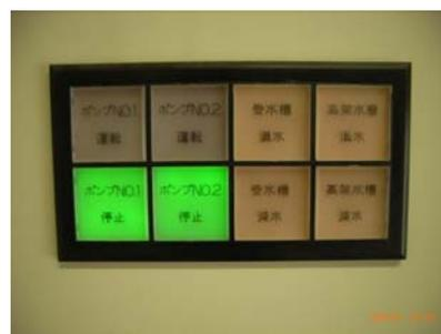
写真 4-3 揚水ポンプ制御盤 警報表示
