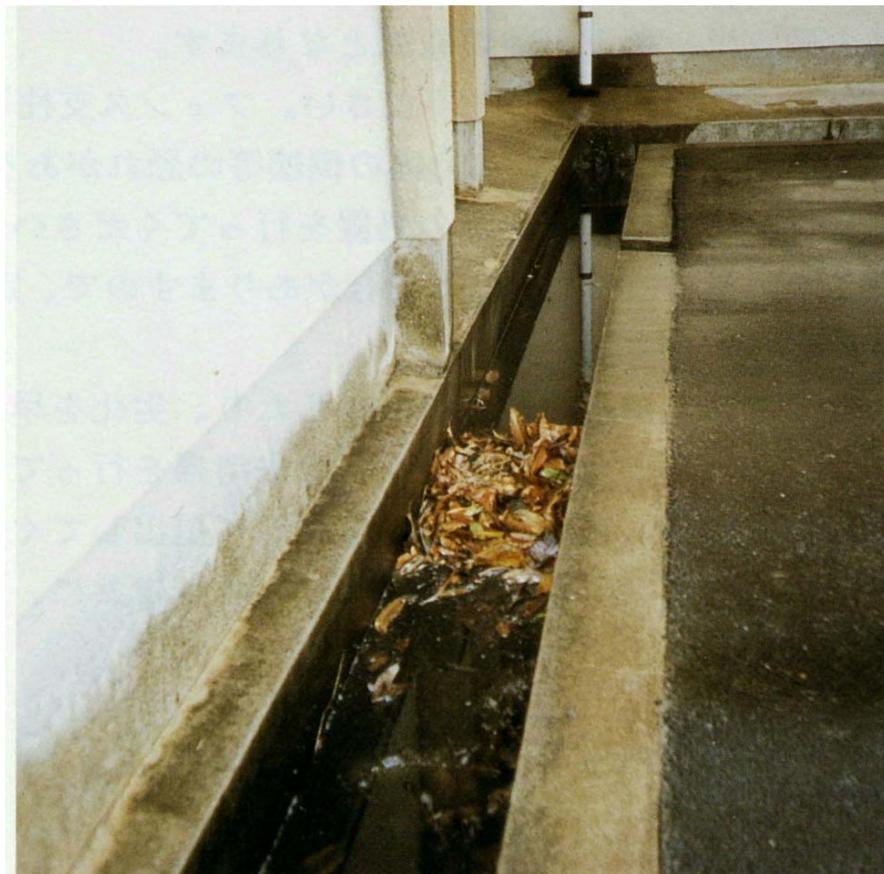
写真 3-2 側溝のゴミつまり
