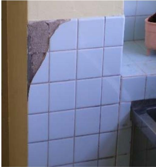
写真 2-8 壁タイルの破損
