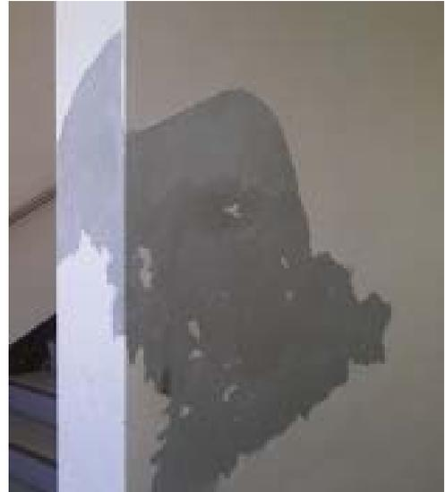
写真 2-9 内壁塗装の剥がれ
