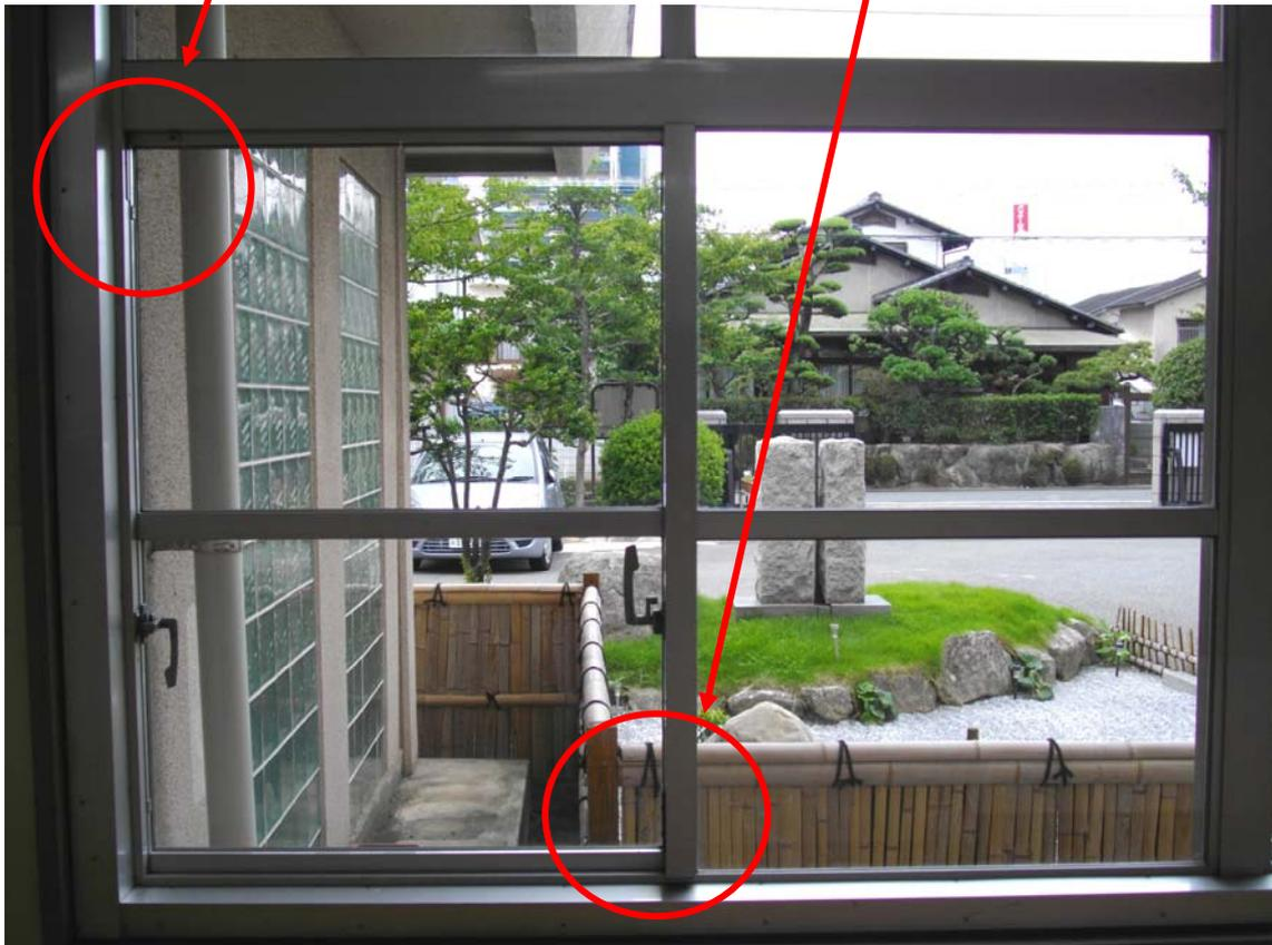
写真 2-3 片引き窓に取り付けられている落下防止材
