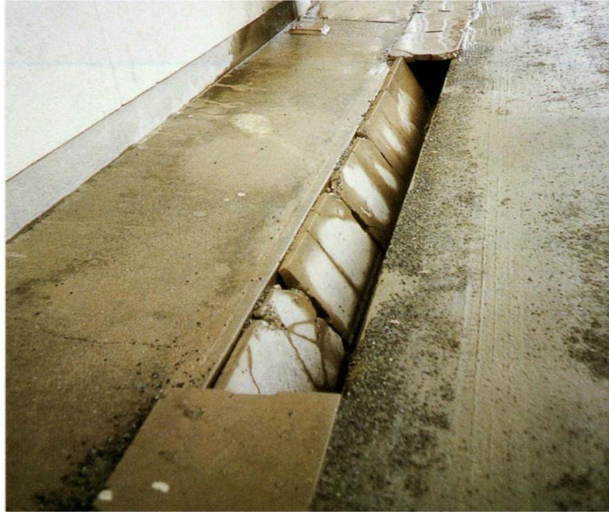
写真 3-1 側溝の蓋の破損
