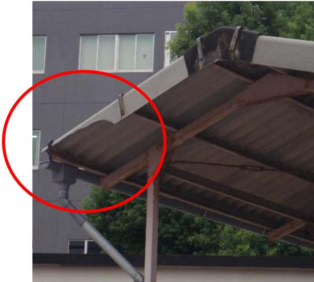
写真 3-1 屋根スレートの破損
