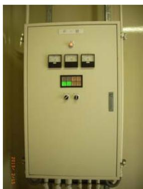
写真 4-2 揚水ポンプ制御盤
